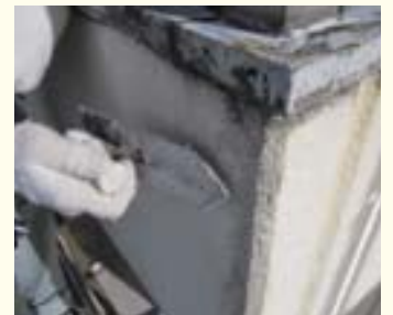
ALC 破損部補修
