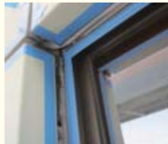
シーリング養生
