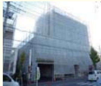
外部足場架け状況
