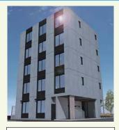
建設地:東京都練馬区東大泉 建物構造規模:壁式鉄筋コンクリート造 地上 5 階建て
