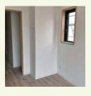
③居室内は、クロス貼 りとスイッチ・コンセン トプレート取付が完了し ました。あとは木製建具 の吊り込みが終われば、 室内クリーニングを待つ のみです。
