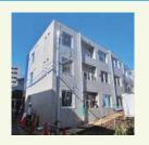
①足場が解体され、建物 全体が姿を現しました。 室内も器具付けが進み、 エアコン室外機も設置さ れました。打ち放しの外 壁がスッキリとした印象 を与えます。
