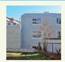
③外観(裏側)の様子 です。敷地に高低差があ るため、地上2階・地下 1階になっています。屋 上にある給湯器・エアコ ン室外機は、路上からは 直接見えない位置に設置 しています。
