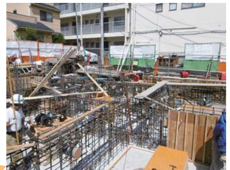
基礎型枠建込み
