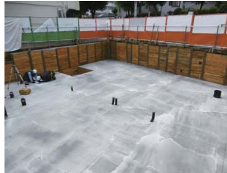
捨てコン打設
