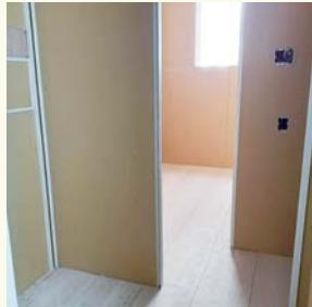
② 壁ボードと床フロア一貼完了の様子です。床の養生後、クロスパテ処理とクロス貼に入ります。
