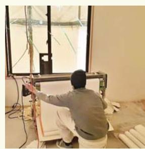
② クロス糊付け中の様子です。天井から床までの寸法にカットしたクロス材に機械で糊を付けていきます。
