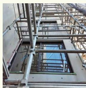
① アルミサッシ取付完了の様子です。外部の塗装も続けて行います。
