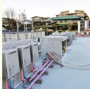
③ 屋上シート防水完了、給湯器取付・エアコン室外機設置中の様子です。下から機器類が直接見えない様工夫されています。
