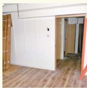
③ 室内の天井と壁クロス貼り完了の様子です。この後、木製建具の搬入・取付を行います。
