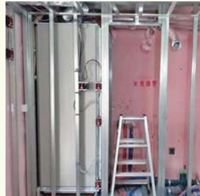
① 室内間仕切（LGS）設置状況の様子です。スイッチとコンセントBOXを取り付け、電気配線を落し込みました。給水配管・給湯配管・排水配管も設置し、シャワーユニットの組立完了しました。
