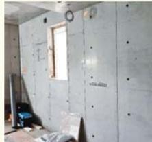
← 1階居室の状況です。壁・スラブともコンクリートの地肌が綺麗です。外壁内側は発泡ウレタン断熱材吹付後、LGSを建て、石膏ボード貼りをします。
