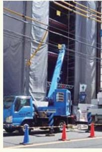
← 外壁や間仕切り壁に取り付けるALC板の搬入状況です。足場の一部を解体し各階にクレーンで搬入します。
