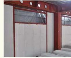
← 各階に搬入したALC板を外壁に取り付けた状況です。開口部には鉄骨の下地を配置して、サッシ等を溶接して取り付けます。
