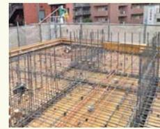
← R階床配筋完了の状況です。配筋検査完了後、コンクリート打設になります。その後、立ち上り(パラペット)や機械設置台等の打設を行い上棟となります。
