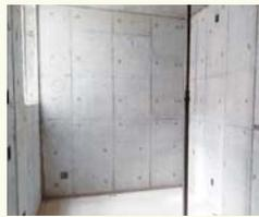
← 1階居室の状況です。外壁側は発泡ウレタン断熱材の吹き付け後、GL工法にて石膏ボードを貼ります。
